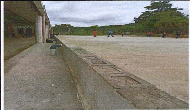
Foto 2: Mejoramiento de losa de patio.
