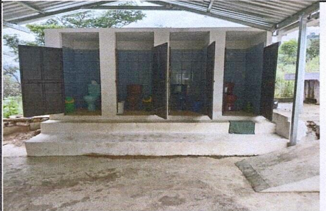
Foto 4: Mejoramiento de servicios sanitarios.
